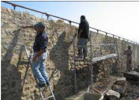
Travaux de restauration du site archéologique de Tholon à Martigues (2012)
